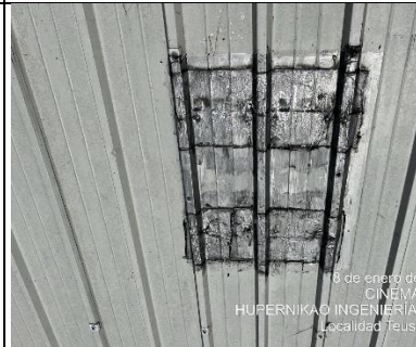
Diagnostico cinemateca cubierta sur
