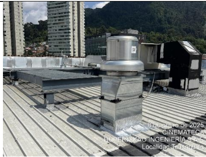
Diagnostico cinemateca cubierta sur
